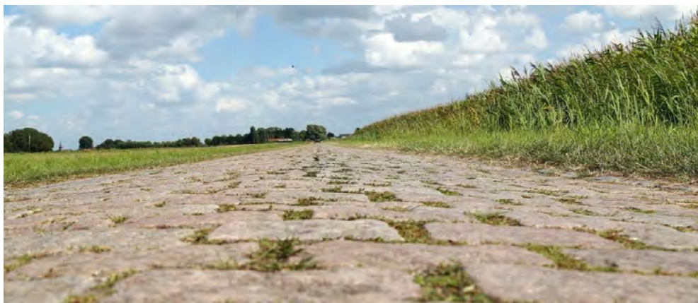
Tramo de adoquines
